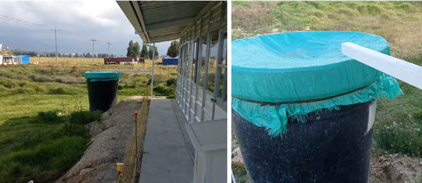
Recolha de água pluvial em site de obra (Colômbia).
