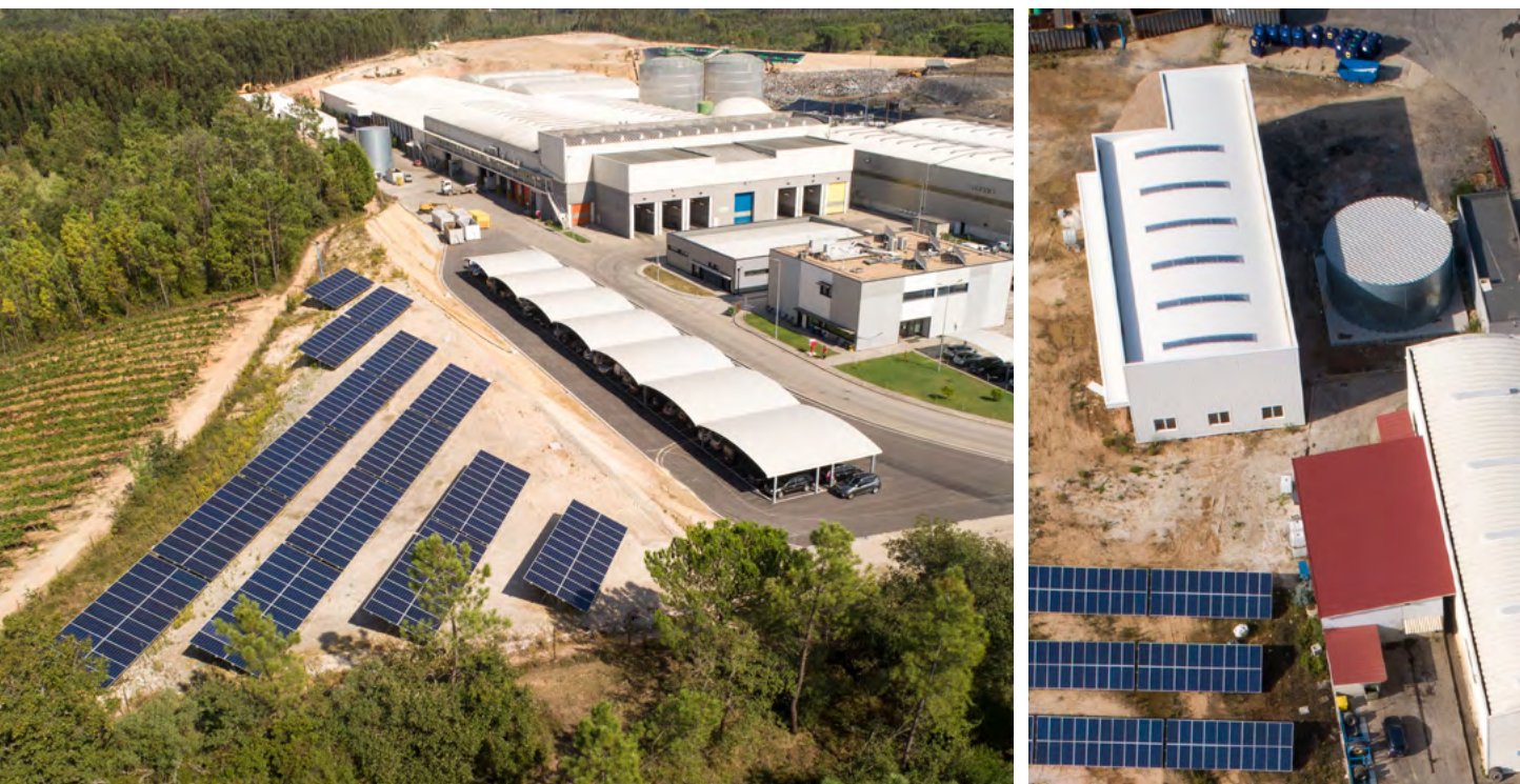
Parque solar fotovoltaico e telhas translúcidas instaladas nas áreas fabris da Ersuc, em Aveiro e Coimbra (EGF, Portugal).
