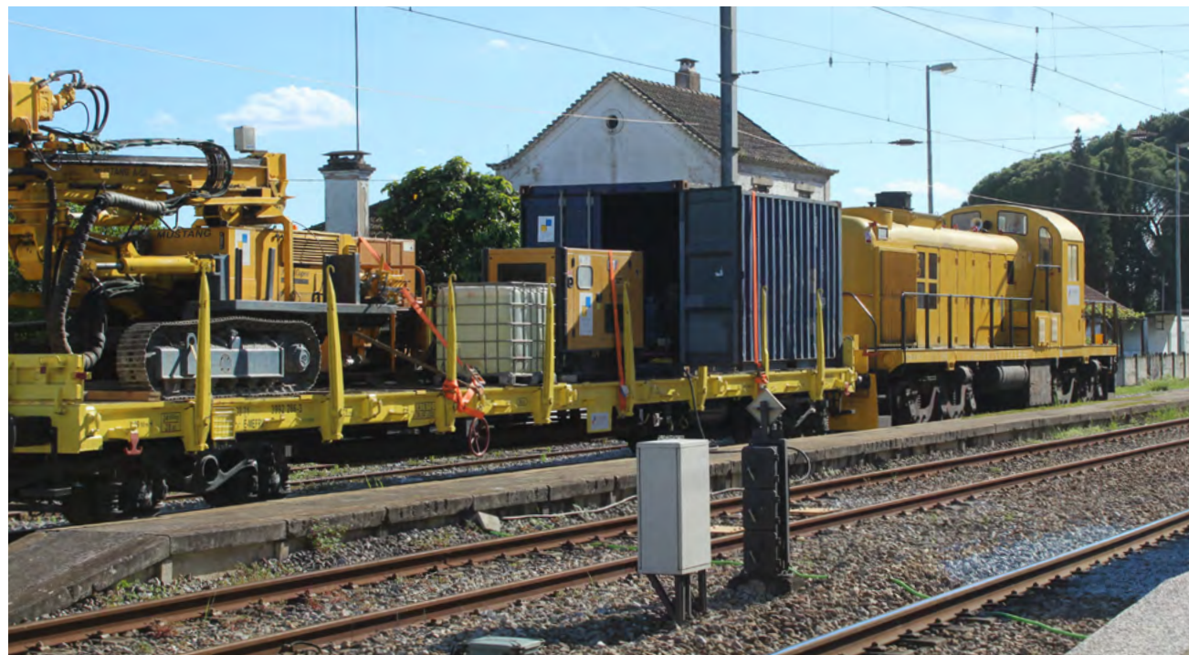
Projeto GroutRail – Reabilitação de Plataformas Ferroviárias, com tratamento de solos, MEEC (Portugal).
