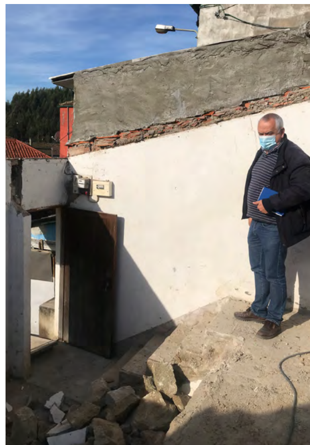
Obras de reparação da habitação (Portugal).
