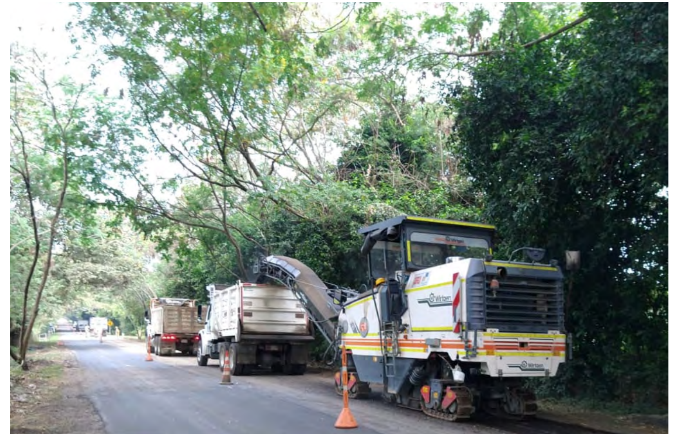
Uso de pavimento reciclado no projeto de concessão de Cambao Manizales (Colômbia).
