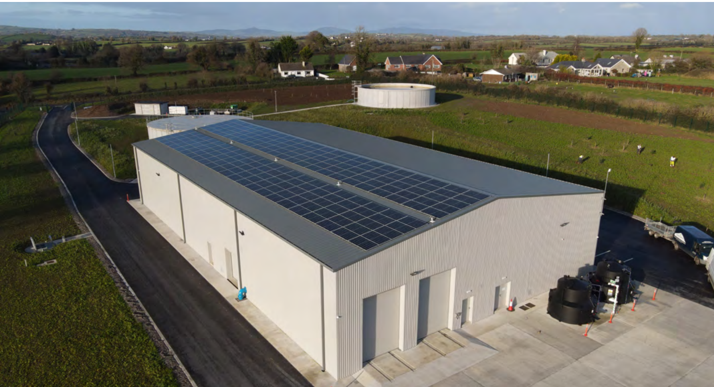
Sistema solar fotovoltaico, ETA de RWSS de Thurles (Irlanda).
