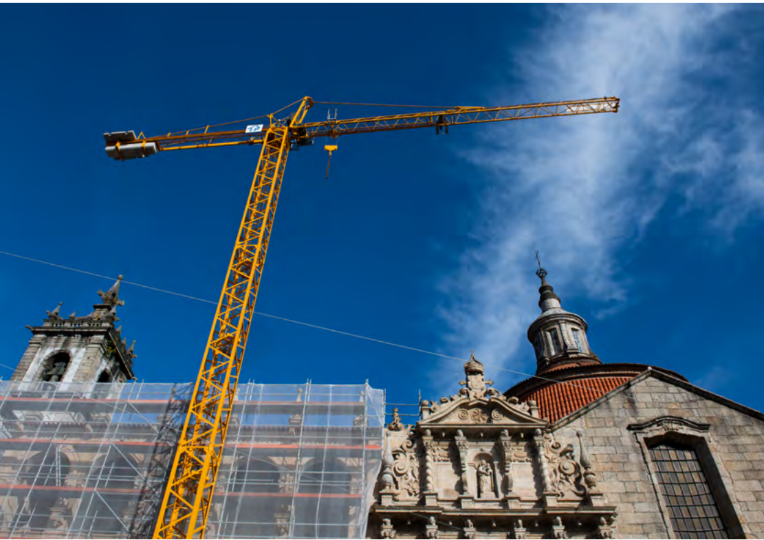
Reabilitação da Igreja e Claustro de São Gonçalo de Amarante (Portugal).
