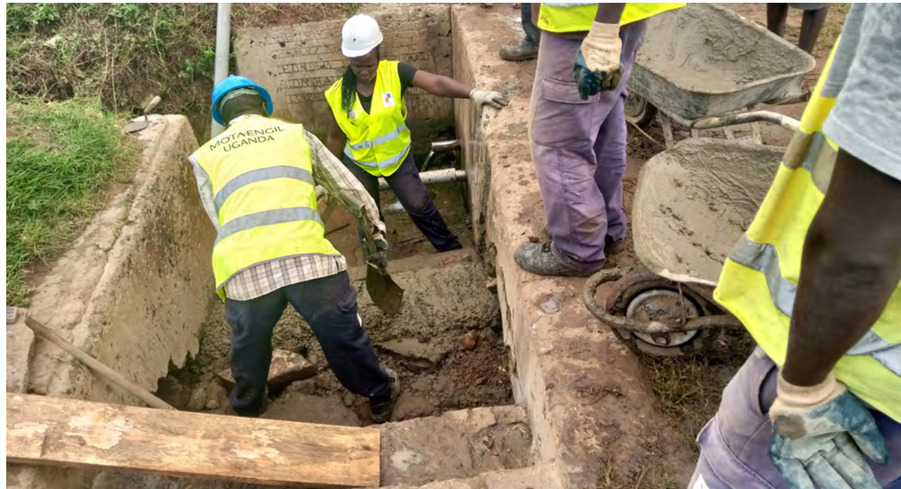
Obras de melhoria em fonte de água, na vila de Kapokin (Uganda).
