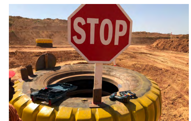
Novo sistema de fixação da sinalização vertical com recursos a pneus usados, Guiné (Mineração).
